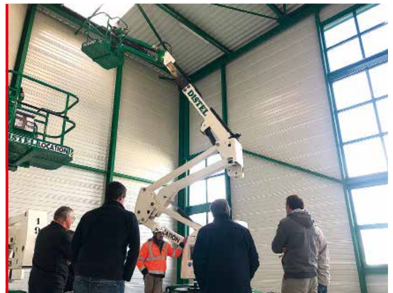
Les nacelles permettent de sécuriser le travail en hauteur. À condition d'être utilisées correctement.
